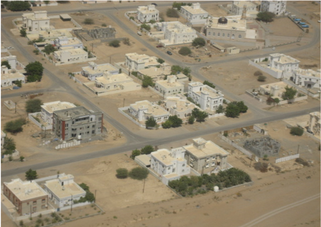
الشكل ١٠. الموالج: حي جديد للفئات المتوسطة في شمال العاصمة طور البناء. الصورة للباحث، ٢٠١١
